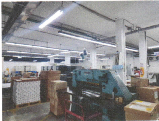
Área de la Planta (Luminarias en buen estado)
