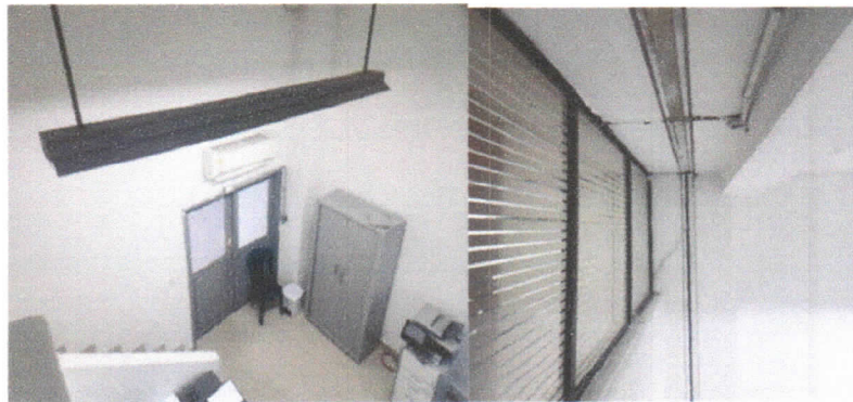
Área Administrativo (no se evidencian cables sueltos)
