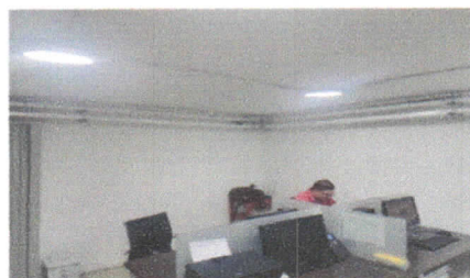
Área de Control interno (No se evidencian cables sueltos)
